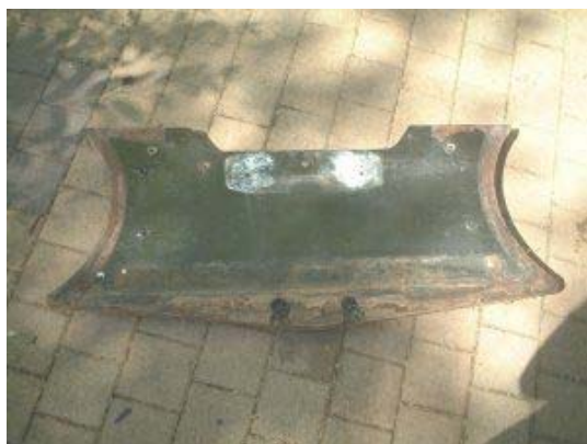
En effet, le bois du tableau est complètement rongé
