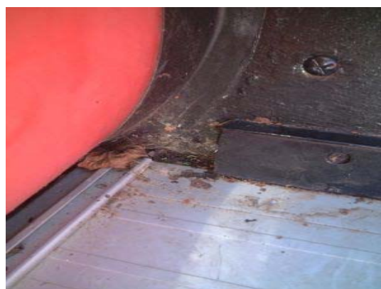
Les points qui lâchent sont surtout les parties immergées Vérifiez bien l'état des jointures
