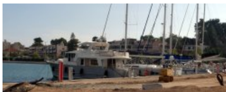
Marina, quai nord en travaux
