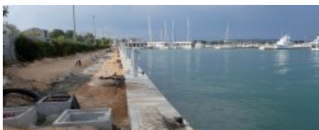
Marina, quai ouest en travaux
