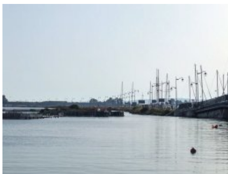
Vieux canal et nouvelle digue
