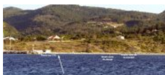
Balisage de l'accès au port et de la chambre
