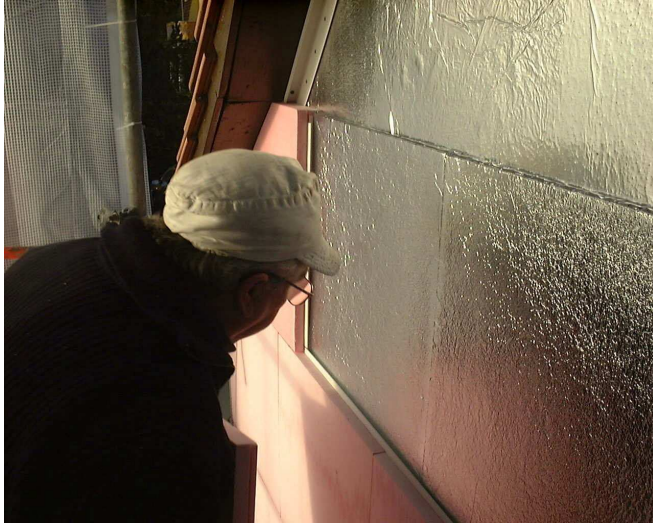
Figure 7 : Isolation d'une façade. En rose : panneaux de polystyrène en cours de montage (source : www.vip-bau.de )
