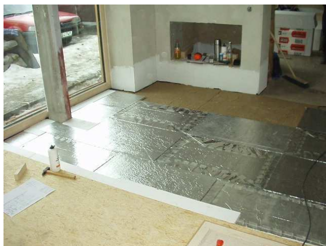
Figure 6 : Rénovation : Isolation du sol : OSB au 1er plan, VIP au centre et softboard au fond (source : www.vip-bau.de)
