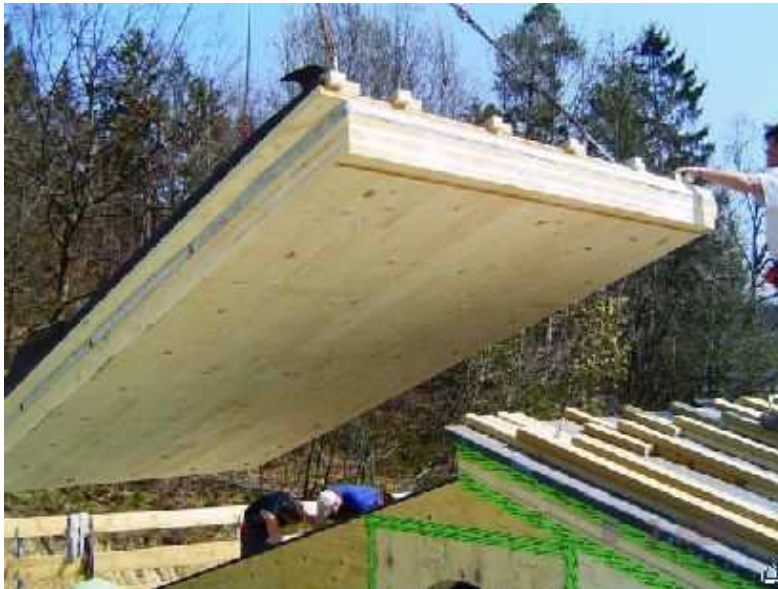
Figure 8 : Toiture préfabriquée qui incorpore un PIV (en gris sur la photo) (source : http://www.enob.info/en/new-technologies/projects/details/sandwich-building-elements-with-vacuum-insulation/ )
